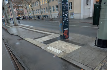
DIN-Absenkung an der 2025 sanierten Straßenbahnhaltestelle Löbdergraben. Hier schränken ein fest installierter Blitzer und ein Oberleitungsmast den Wendebereich und die Sichtssachen an der Absenkung ein. Foto: Florian Reißner
